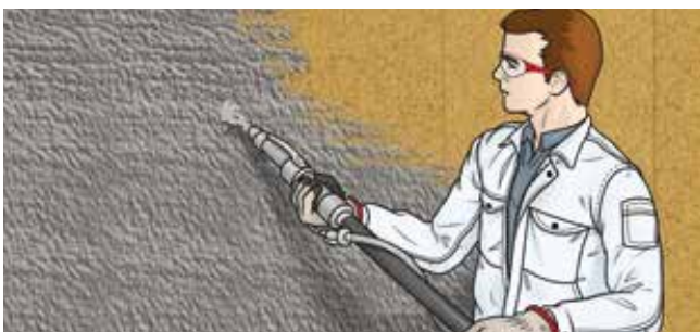
2 Erste Lage Armierungsputz auftragen.
