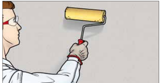
6 Die Fläche mit dem Farbroller bearbeiten.
