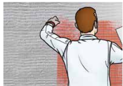
6 Systemgewebe straff und faltenfrei einbetten. Die einzelnen Gewebekarten müssen sich ca. 10 cm überlappen und vollständig mit Armierungsmörtel überdeckt sein.
