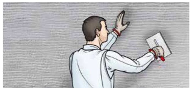
3 Armierungsputz mit Zahntraufel oder Zahnkartätsche verziehen und waagrecht aufkämmen.
