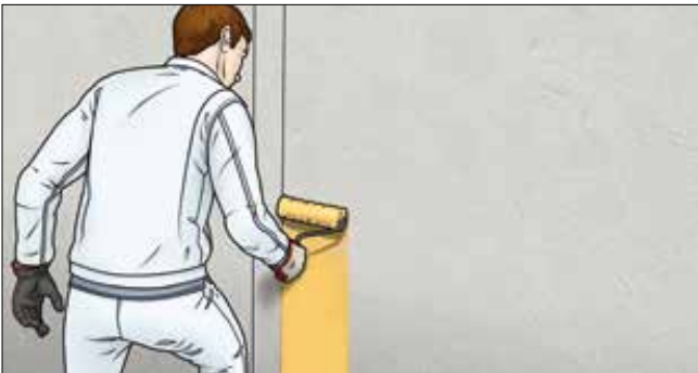
5 Der erste Rollenstrich sollte von einer Ecke anfangend immer von unten nach oben beginnen.
