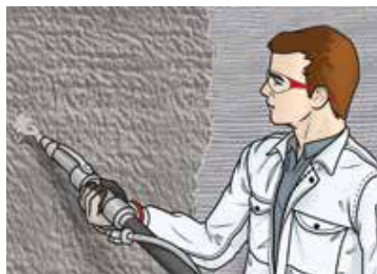
5 Zweite Lage Armierungsputz bis zur systemgeforderten Enddicke auftragen.
