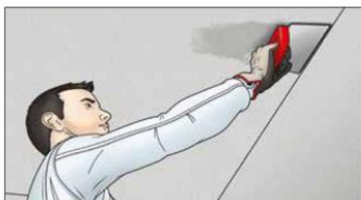
Trennschnitt mit Stucksäge
