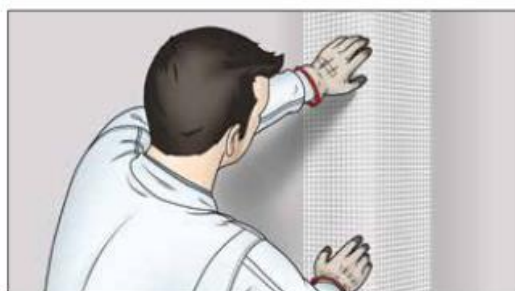
Einbetten des akurit GEB Eckwinkels
