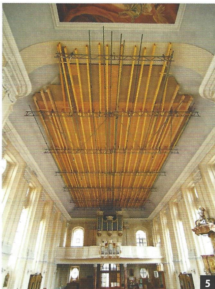
Abb. 5/6: Eine Stützkonstruktion sicherte das Deckengemälde, während der Putzträger ausgetauscht wurde.
