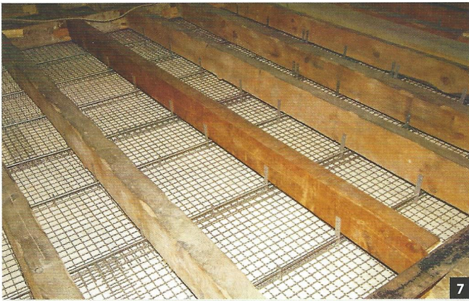
Abb. 7: Eine Mattenarmierung aus Wellengitter und zwei Lagen von Rundstäben bilden den neuen Putzträger.
