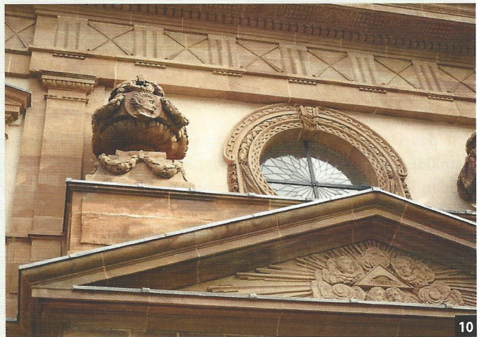
Abb. 10: An der Sandsteinfassade kam ein Fugenmörtel mit natürlich hydraulischem Kalk als Bindemittel zum Einsatz.
