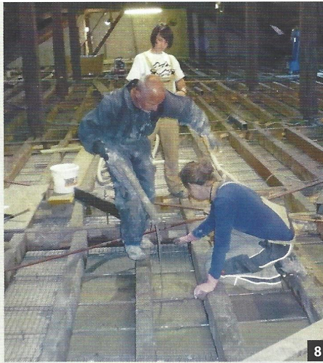
Abb. 8: Der Vergussmörtel wurde auf der Decke und den Randbereichen verteilt. Dazu wurde ein Mörtel entwickelt, der über eine besonders hohe Fließfähigkeit verfügt.
