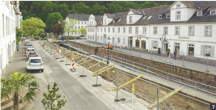
Abb. 7: Damit die Straße auch von Feuerwehrfahrzeugen befahren werden kann, sichert eine Konstruktion mit Fangebalken die Kanalmauern.
