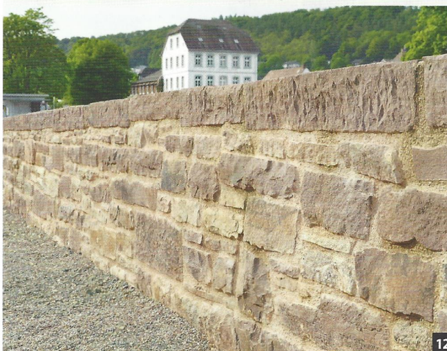
Abb. 12: Ästhetische Gesichtspunkte spielten bei der Mörtelauswahl eine große Rolle. Die Farbe passt zum Sandstein, ohne ihn zu dominieren.
