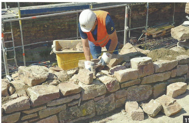
Abb. 11: An einigen Stellen musste das aus mehreren Schalen bestehende Mauerwerk komplett neu aufgemauert werden.
