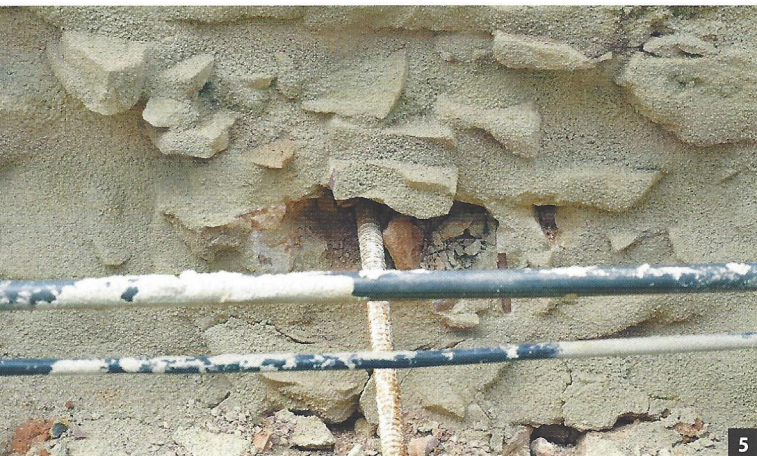
Abb. 5: Eine Konstruktion, um dem Mauerwerk Halt zu geben, sind Erdsnägel.
