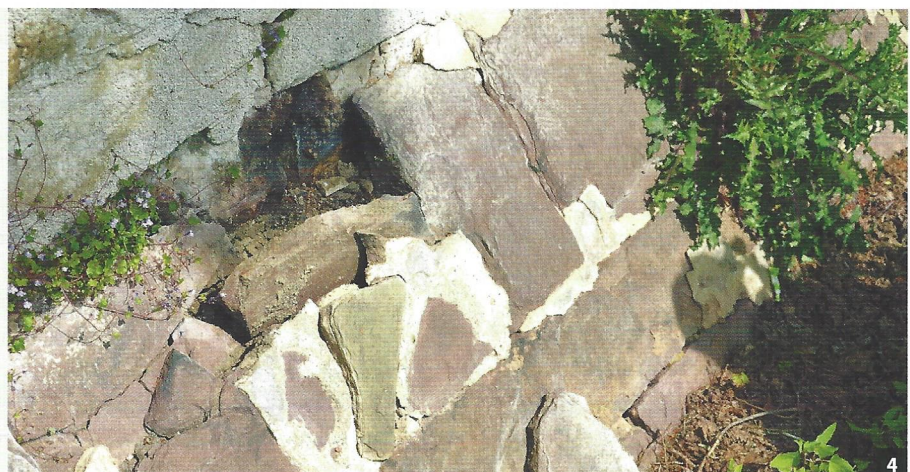
Abb. 4: Steine ließen sich ohne Kraftaufwand per Hand aus dem alten Wandfuß entnehmen.
