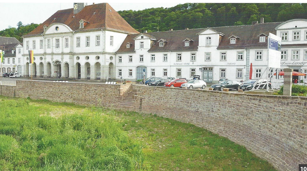
Abb. 10: Drainagerohre und Mörtel mit Drainagekörnung schützen die Mauern vor den Hochwassern, die regelmäßig zu erwarten sind.
