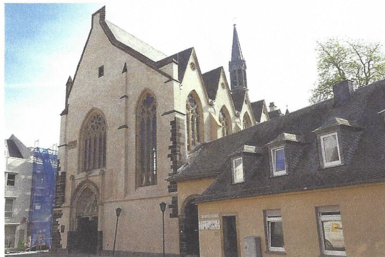
6 Für die Christuskirche wurde ein eingefärbter, nicht wasserabweisender Schläämputz verwendet.
