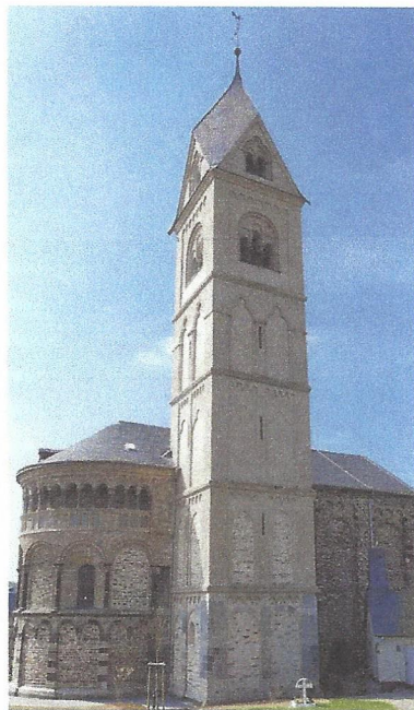
7 Kirche St. Jakobus der Ältere in Lonngig: Nach einem Brand wurde sie mit einem Mauerwerk aus Tuffsteinen und Basalt wieder aufgebaut.
