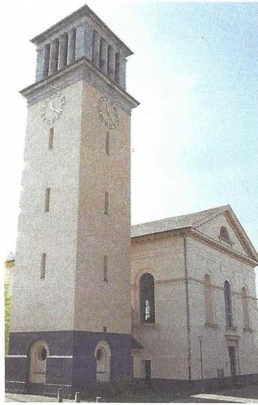
3 Bei der Kirche St. Peter und Paul im Neuwieder Stadtteil Irlich wurde nur der Hauptturm aufgeschläämt. Der Putz des Hauptschiffs erhielt lediglich einen Farbanstrich.
